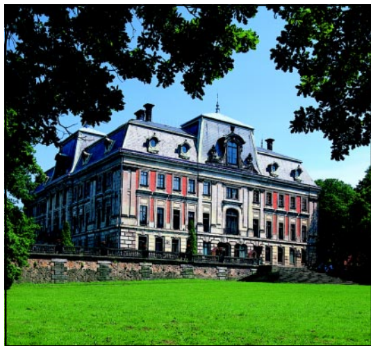
Pszczyna, pałac, fot. P. Piersciński.
