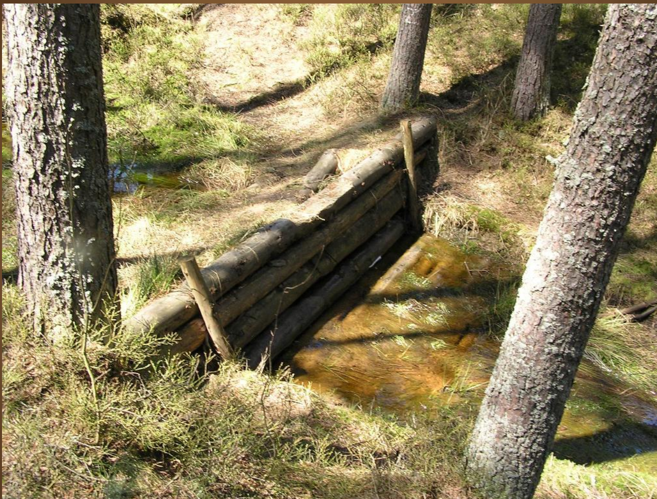
Budowa zastawek tamujących spływ wody w rezerwacie przyrody Bór na Czerwonym
