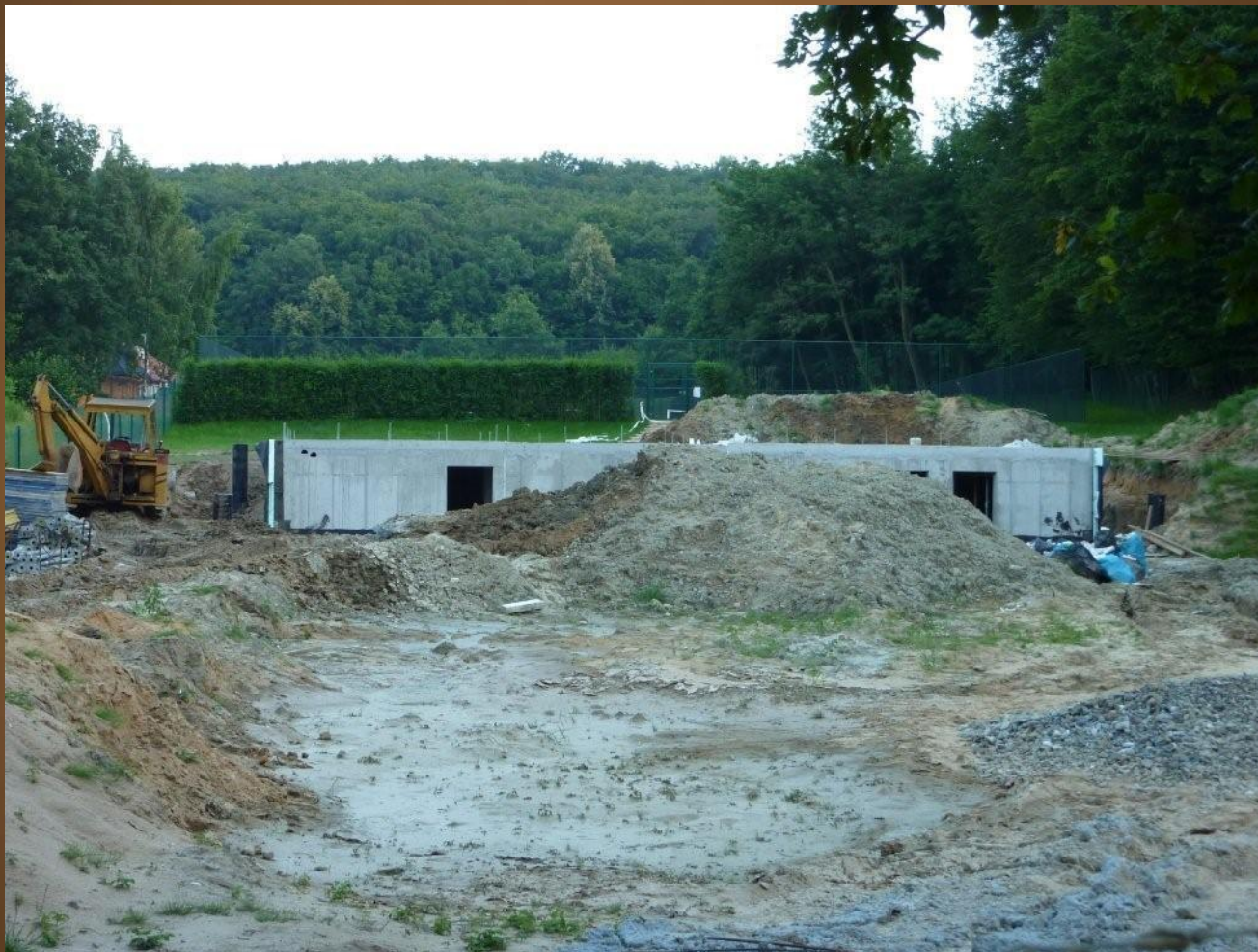
Budowa obiektów przy granicy z rezerwatem przyrody Skołczanka
