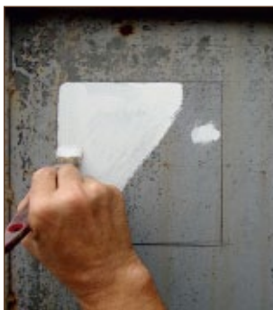
Ryc. 8.8. Malowanie tła płaskim pędzlem, fot. M. Kotarski
