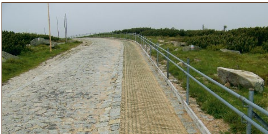
Ryc. 15.20. Wyłożony specjalną plastikową siatką i wyposażony w barierkę pas dla osób poruszających się na wózkach inwalidzkich na Równi pod Śnieżką. Siatka pozwala na wyrównanie nawierzchni przy jednoczesnym zachowaniu jej porowatości (ograniczenie śliskości) i przepuszczalności dla opadów atmosferycznych, fot. K. Kołodziejczyk,
