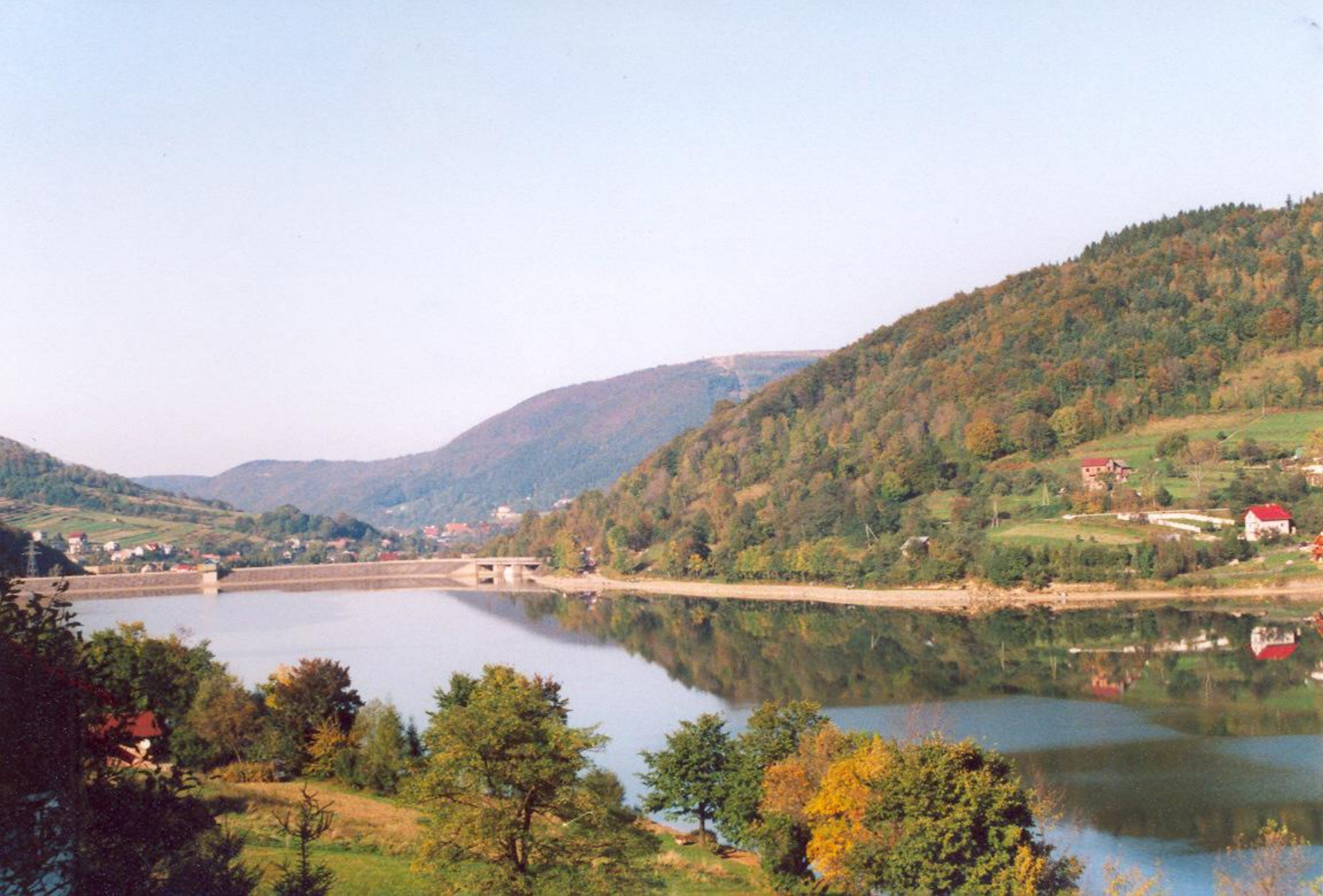
Jezioro Żywieckie z widoczną zaporą w Tresnej
